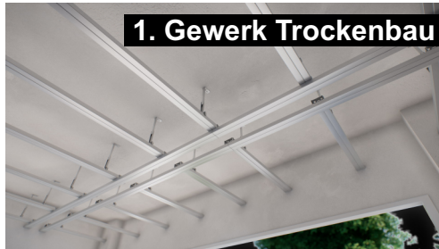
Montage der Trockenbau Unterkonstruktion.
