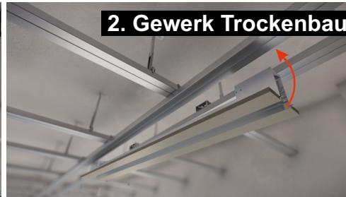
Fertige Schnellbau-Basiselemente NoLimit Plus (kann auch Lüftungselement oder 90° Ecke sein) an der Trockenbau-Unterkonstruktion montieren.
