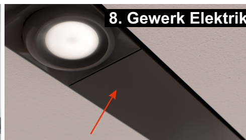
Blindabdeckung zwischen den Leuchten und dem Luftauslass einklippsen.
